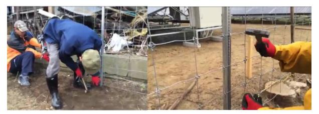
フェンスを伸ばしながら、ステイプルロックポストに、ステイプルをハンマーで打ち込み、フェンスを取り付ける。
