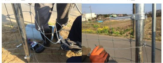
端部ポストにフェンスバンド使い、フェンスを固定する。フェンスバンドは上、中、下に取り付ける。フェンスの端部を図のように、不要部をカットし、端部ポストに図のように巻き付ける
