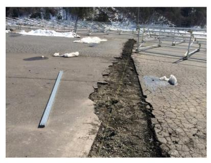
始点終点・コーナー箇所を決め、地上 5cm程度に糸でラインを引きく。 各支柱の上部から 1950mmに印をつけてラインまでランマーで打ち込む。 (1550フェンス+有刺鉄線2段仕様時) 1550mmフェンスのみの場合は 1650mmに印
