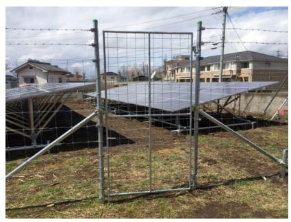
最後に門扉を取り付けます。 隙間などは、ネカセや門扉のヒンジの取り付け位置で調整します。
