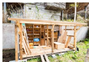
↑暖炉は熱効率がよくないため、手前に薪ストーブを設置し、排気ダクトを暖炉に通している。これも政春さんが工夫した。
