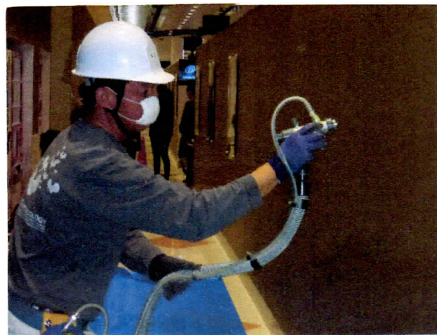
エントランス前通路
