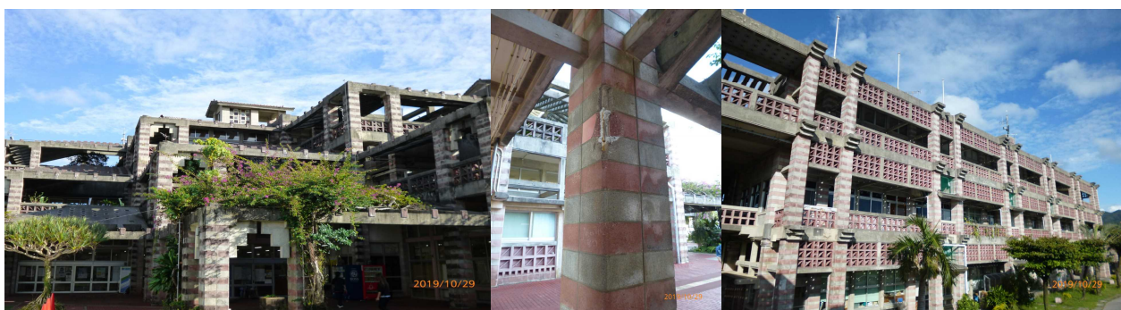
有名な庁舎：耐震判断で建て替えだが！（台風被害や柱に鉄筋が見え隠れ） <風の道を採用した省エネの空調方式の庁舎 37 年が経過>
