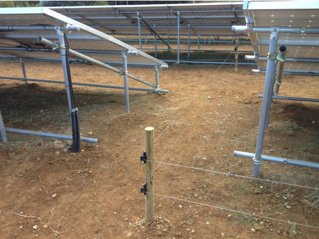
防腐木杭(φ60)とワイヤーによる区分け
