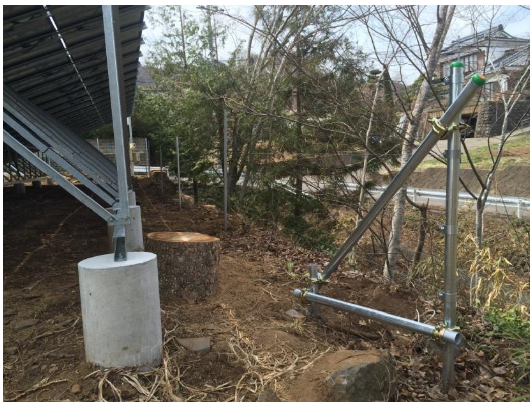
フェンシングワイヤー 4段によるフェンス 30cm間隔の4段 施工高120cm程度
