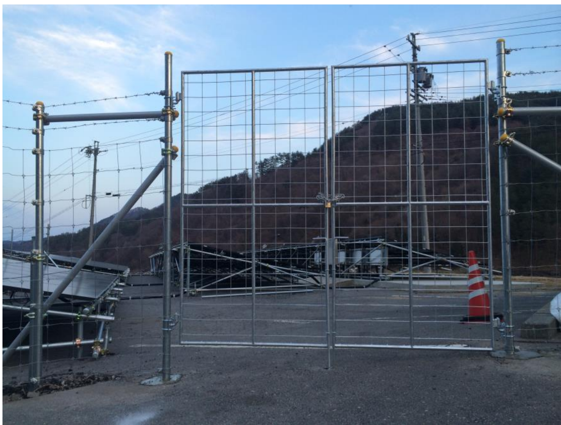
1m幅2基を使用した両扉。
